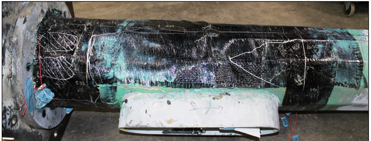
(d) West face – debonded and ruptured FRP
