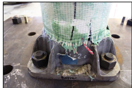
(d) Ruptured FRP fibers on compression side base plate
