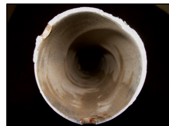
(d) Ruptured section
